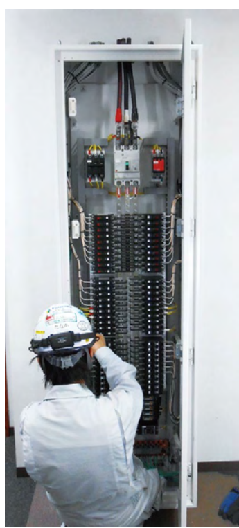
⑤ 結線、整線作業 (P2 施工時間比較①)
