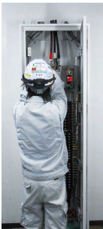
④ 入線孔から外部ケーブルを入線する (P2 施工時間比較①)
