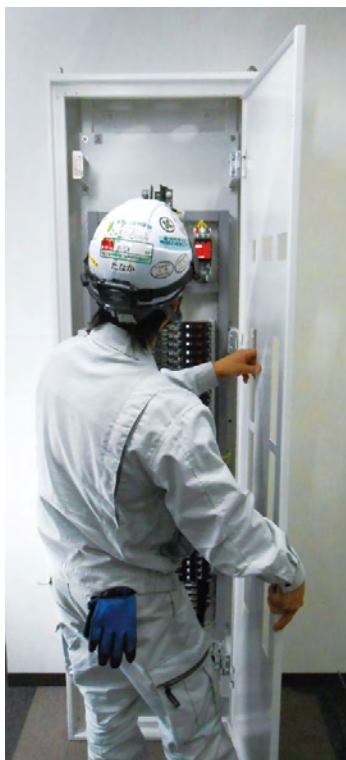
① 盤を据え付けた後、作業スペースを確保して、保護板を取り外す (P2 施工時間比較②④)
