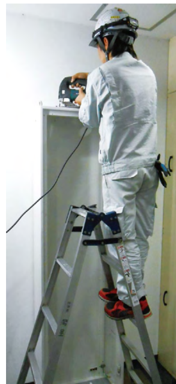
③ 入線孔をホルソーやジグソーで天井に開口する (P2 施工時間比較②)
