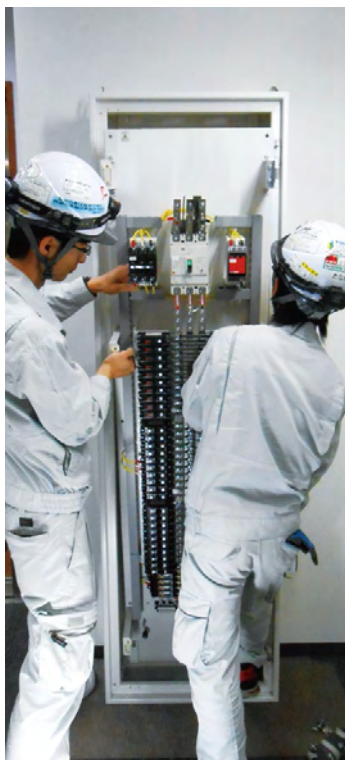
② 内器を一旦取り外し、天井開口の作業準備 (P2 施工時間比較②)
