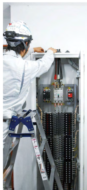
⑥ 外部ケーブルの入線部をパテで隙間を塞ぐ (P2 施工時間比較③)
